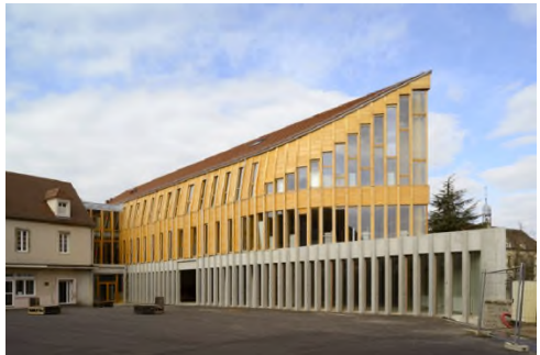
Le collège François Pompon (1965), à gauche avant l'extension de 2016 : socle de béton brute, structure en lamibois en forme de proue, toit à deux pans.
